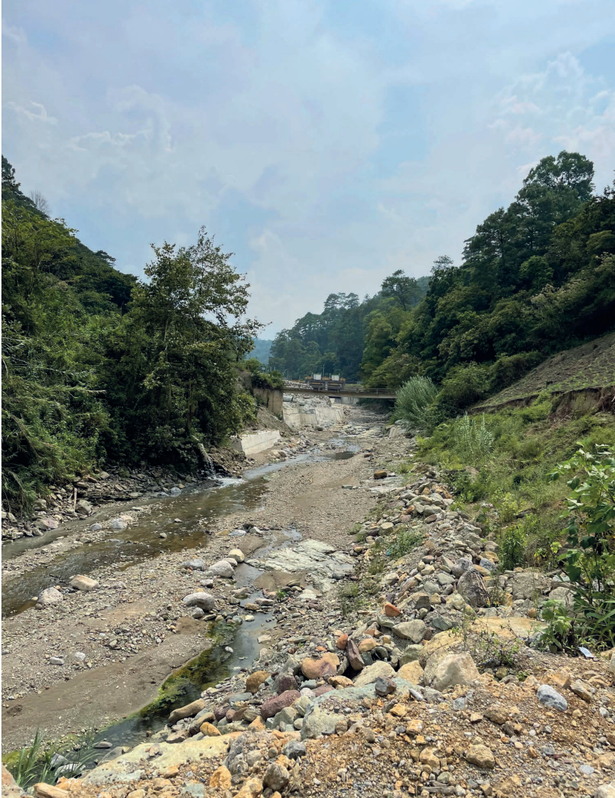
Imagen 9. Rio Cotzal después de pasar por una de las represas derivadoras de Enel, la cual desvía el río a un canal de concreto, dejando el río seco, mayo 2022.
